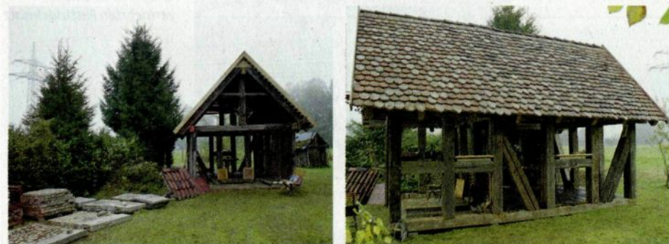
Errichtung eines Hauses mit alten Baumaterialien
