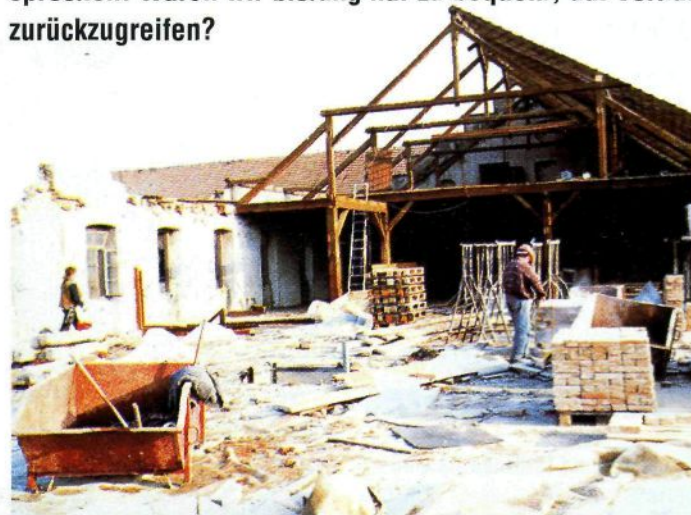
Selektiver Rückbau eines Tabaklagers in Herbolzheim (Schwarzwald)
